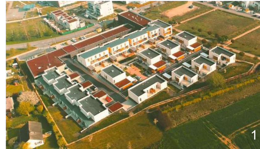
Les locaux d'une gendarmerie et ses 42 logements associés (secteur 1A)
