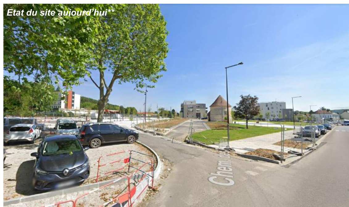
Source : Google Street View (**prise de vue réalisée en juin 2021)
