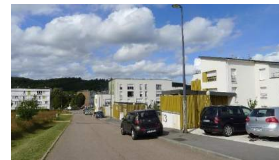
Côté ouest (depuis l'intérieur de la Z.A.C.)
